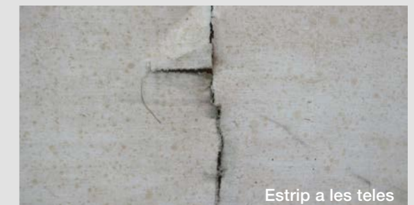
Separació de les dues teles i oxidació dels gavarrots
